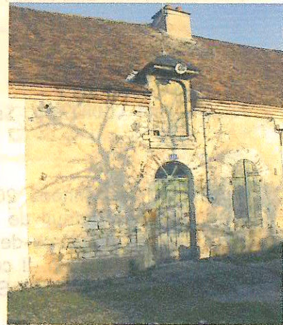
Maison ouvrière, rue du Port.
